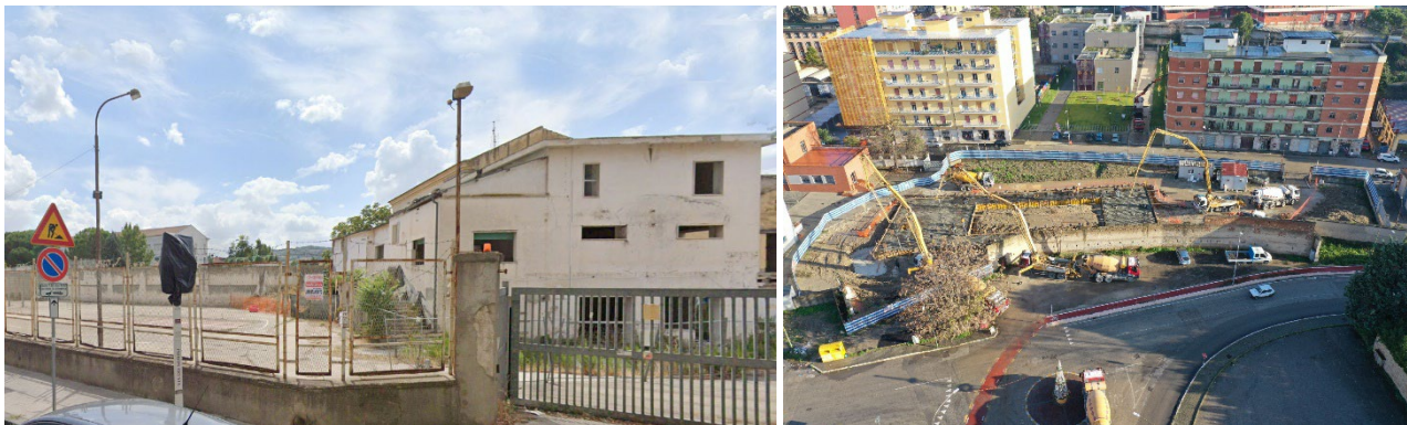
Vista dell'edificio preesistente e foto aerea del getto di fondazione dopo la demolizione
